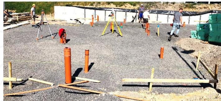
Die Feinabsteckung ist ein entscheidender Schritt in der Bauphase, der unmittelbar vor Beginn des Schalens erforderlich wird. Dabei übertragen wir die Hauptachsen des Gebäudes präzise auf das Baufeld. Dies geschieht mittels Nägel, die auf den Schnurgerüsten angebracht werden. Durch das Verbinden dieser Nägel mit Schnüren entstehen Schnittpunkte, die exakt die Ecken des geplanten Gebäudes darstellen.
