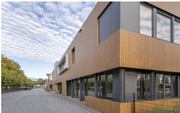
Firmenhauptsitz EromesMarko_Wijchen, NL | Fassadenpaneele aus gepresstem Basaltgestein | Bild: Rockpanel
