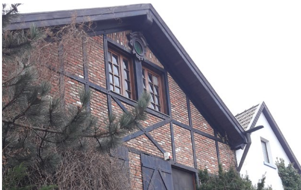
Bestandsgebäude Alfter, Bild: ulrich hartung GmbH
