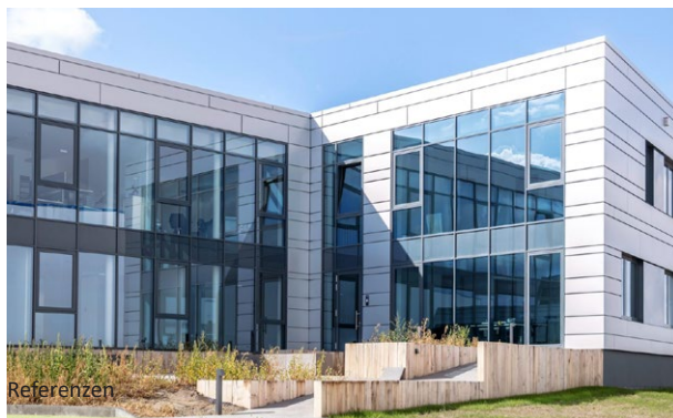
Firmengebäude Flachstahl_Werl | Fassade aus Aluminiumpaneelen | Bild: BEMO Systems/vor-ort-foto.de/Photostudio Siciliano
