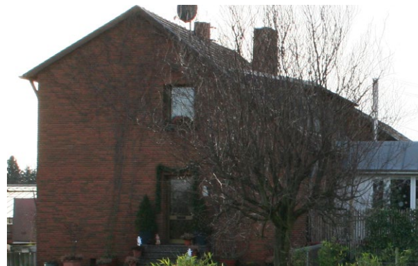
Bestandsgebäude Alfter, Bild: ulrich hartung GmbH
