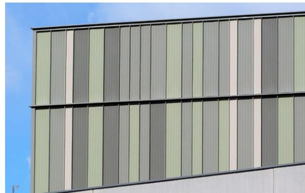
Hochregallager Meraner Mühle_Lana, Südtirol | Fassade aus Aluminiumpaneelen | Bild: BEMO Systems
