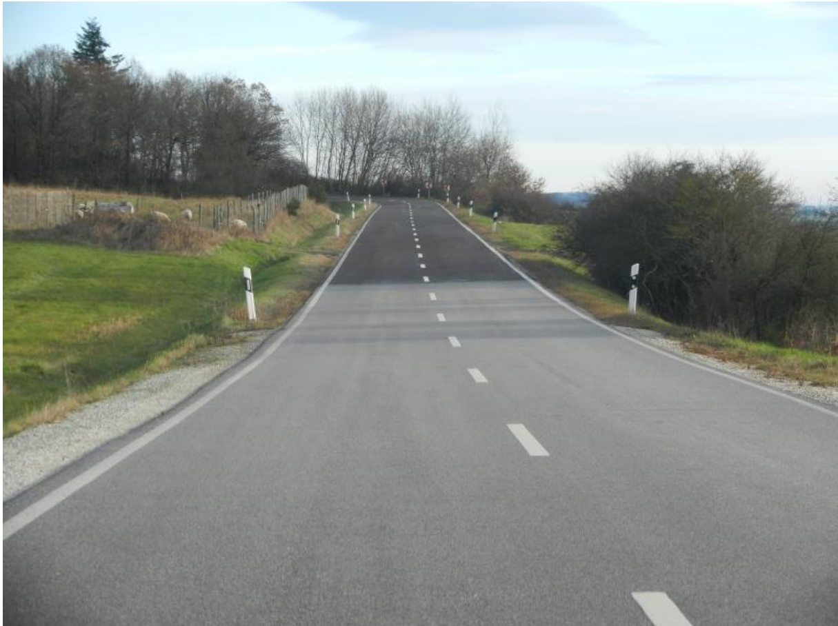
Abbildung 1: Beispielhafte Veränderung Straßenoberfläche nach 2 Jahren Befahrung, mit und ohne Aufhellungsgestein
