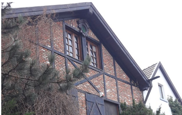
Bestandsgebäude Alfter, Bild: ulrich hartung GmbH
